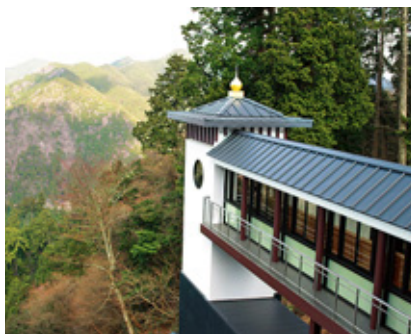
高野山駅のエレベーター棟
