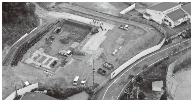
給食センターの基礎工事現場
