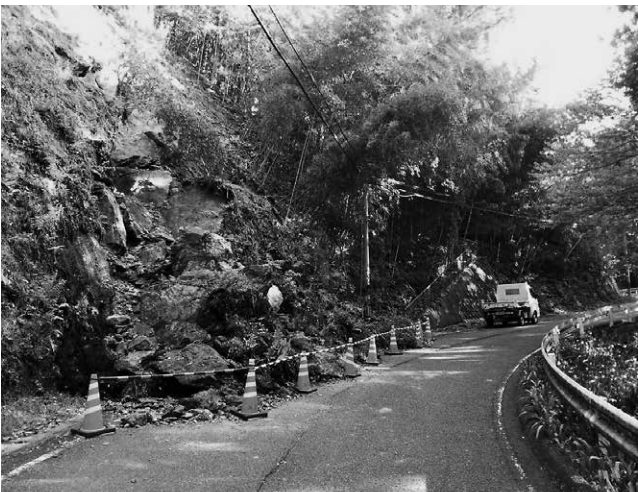
町道西郷1号線法面崩壊
