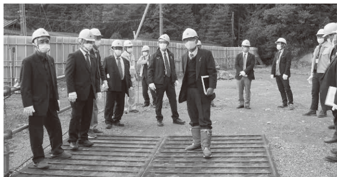
整地工事が進む現場説明
